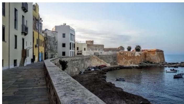
mura di Tramontana
